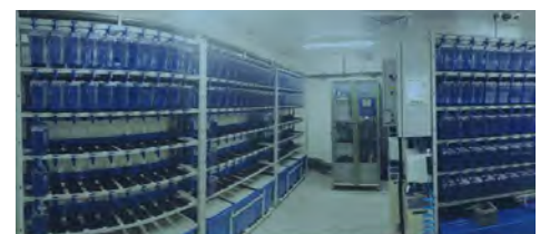
Hébergement principal. 450 aquariums et 4 systèmes aquacoles indépendants, pour une capacité d'accueil d'environ 13 500 poissons
